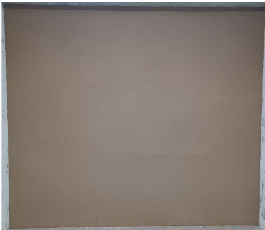
Bild A 2: Ansicht Prüfobjekt von der Empfangsraumseite
